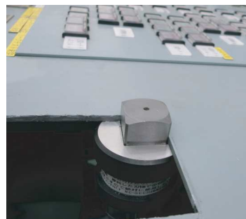
4.5 mm 厚の既設配電盤のパネル改造工事例
